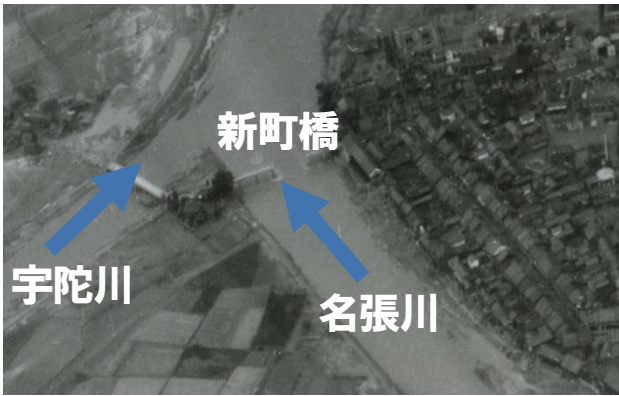
写真-1 昭和34年9月伊勢湾台風により流出した新町橋
