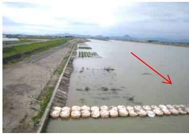
図-4 野洲川右岸ヨシ帯再生工事施工後 (2010年4月)
