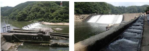
図-1 各堰の全体図(左：相楽発電所取水堰 右：大河原発電所取水堰)
