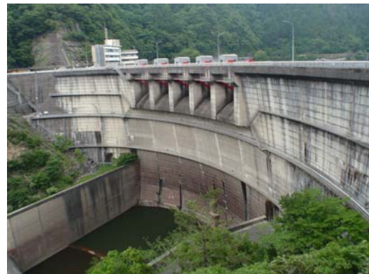
写真-1 大迫ダム全景
