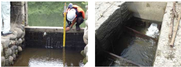
図-2 各魚道の課題箇所(左:相楽発電所取水堰魚道の落差 右:大河原発電所取水堰魚道の潜孔 ※いずれも魚道内の流量を下げ、水位を低下させた状態で撮影)
