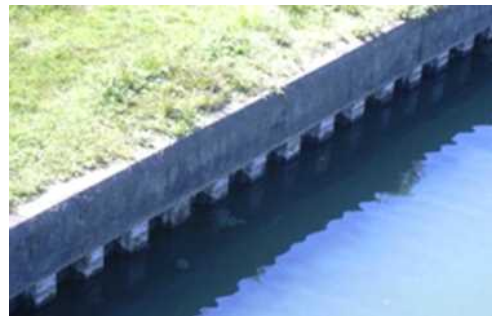
図-3 野洲川河口部の矢板護岸
