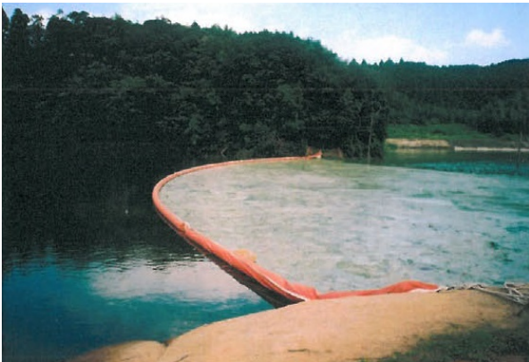
写真-3 分画フェンス設置状況(ゼニヤ海洋サービス分画フェンスカタログP6より)
