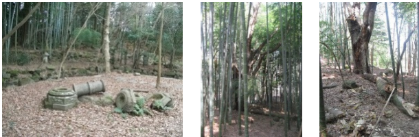
図-4 庭園の毀損状況
