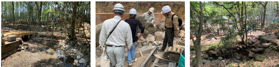
図-15 高畑町裁判所跡地の整備の進捗状況（左：園池，中央：石積み，右：茶室及び滝周辺）
