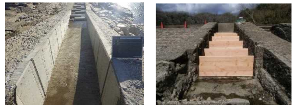
図-9 施設管理者により実施された魚道の補修と改良(H31.2)
