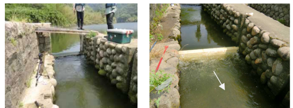
図-6 相楽発電所取水堰魚道の試験的な改良状況
