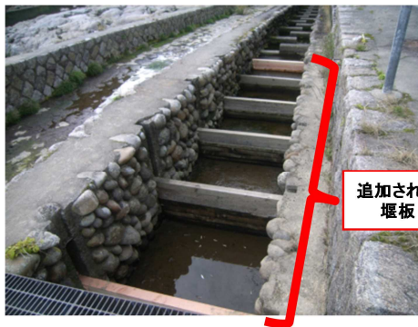
図-7 施設管理者による相楽発電所取水堰魚道の改良状況
