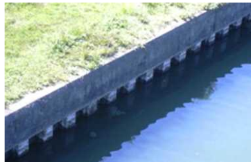
図-3 野洲川河口部の矢板護岸
