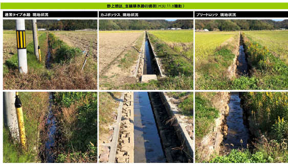
図-7 環境配慮型水路の現状 (H30. 11. 8 撮影)
