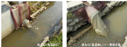
図一13 水田降下調査位置と排水口の形状 調査結果を表一7に示す。
