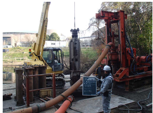
写真-2 ハンマグラブによる転石除去（右はTBH機械）
