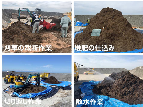
写真-1 堆肥製作の様子
