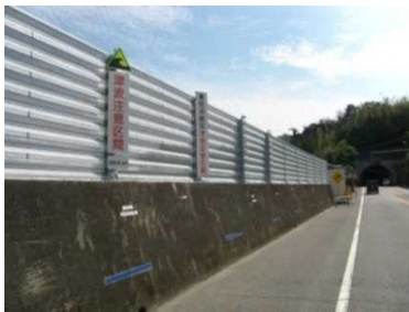
写真-3 越波防止柵 (メタル)
