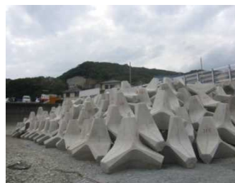
写真-1 消波ブロック
