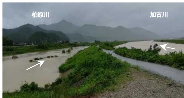
写真-4 背割堤部の状況(2018. 7. 8早朝)
