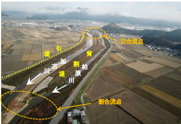
写真-1 加古川・柏原川背割堤
