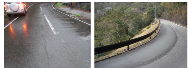
図6 路面の変状（左：クラック 右：オーバーレイ）
