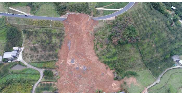
図2 斜面崩落写真
