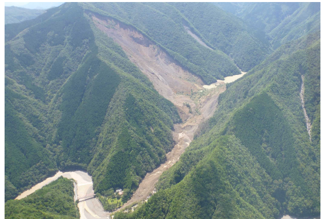
図-1 2011年台風12号による深層崩壊(赤谷地区) 幅:460m 高さ:600m 長さ:850m 崩壊土砂量:約11378000m 3
