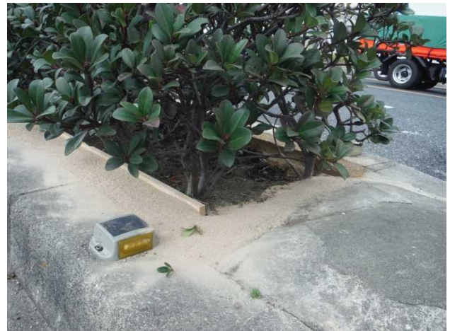
写真-2 土系舗装
