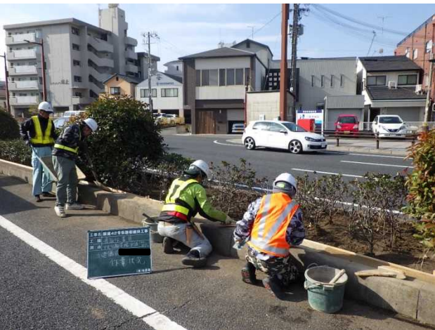
写真-6 土系舗装施工状況
