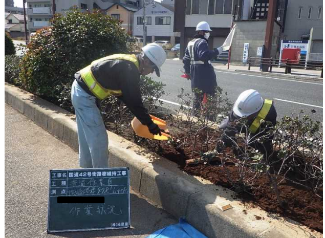
写真-8 マルチング材施工状況
