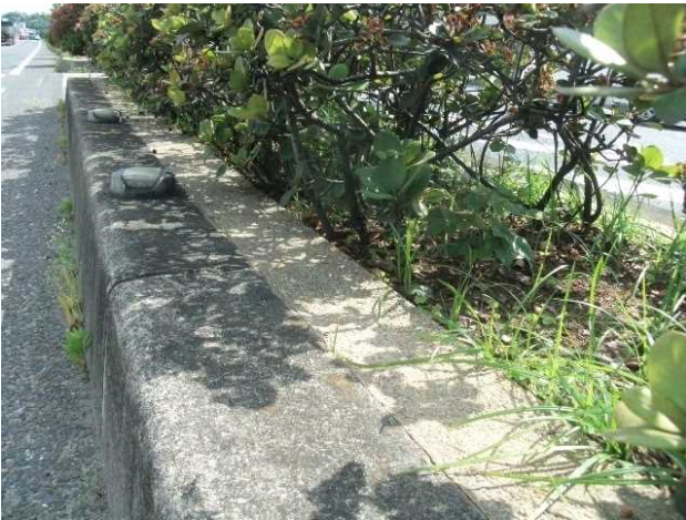
写真-11 根元部分 (対策箇所)
