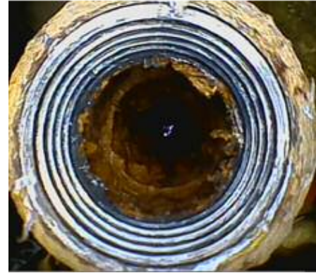
写真 - 3 孔内洗浄前の孔内状況 (No.10)
