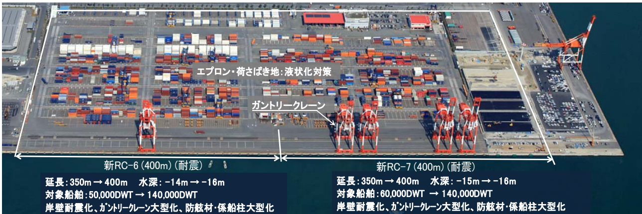
図-1 六甲アイランド地区コンテナターミナルRC-6,7 高規格化 整備概要
