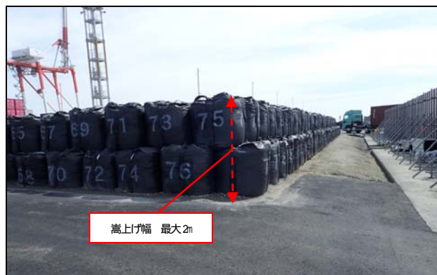
写真-9 大型土のう設置状況
