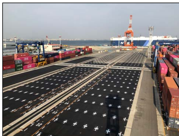
写真-10 工事完成時 (stage4-2工区)
