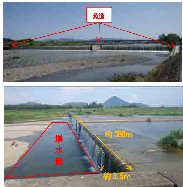
図-2 落差工全景
