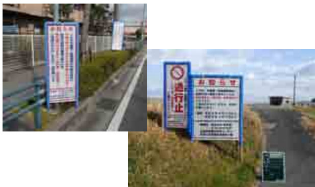
図-6 立看板の設置状況
