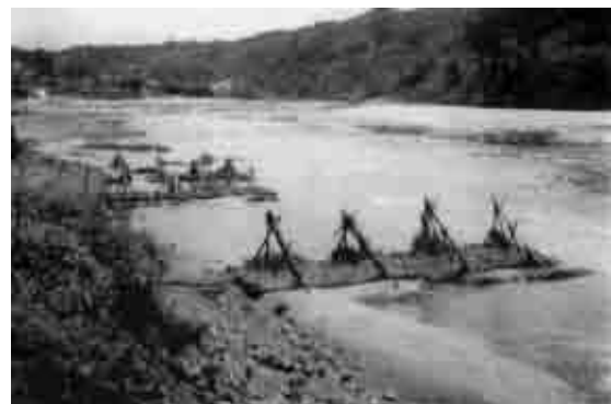
図-1 木津川で1953年に設置されていた聖牛
