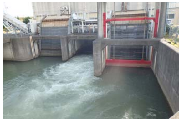
写真-8 ポンプによる浄化運転状況
