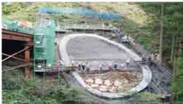
写真-3 付替県道橋梁下部工見学
