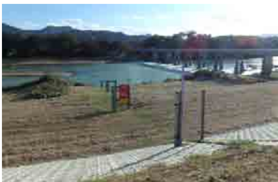
写真-6 水位観測所の状況
