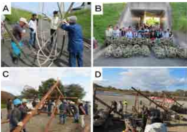
図-5 講習会当日の様子 (A-B:竹蛇籠の製作, C-D:中聖牛の製作と設置)
