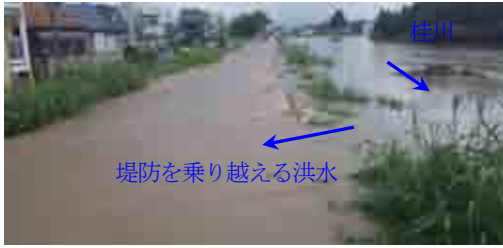
図-2 久我地区堤防越水
