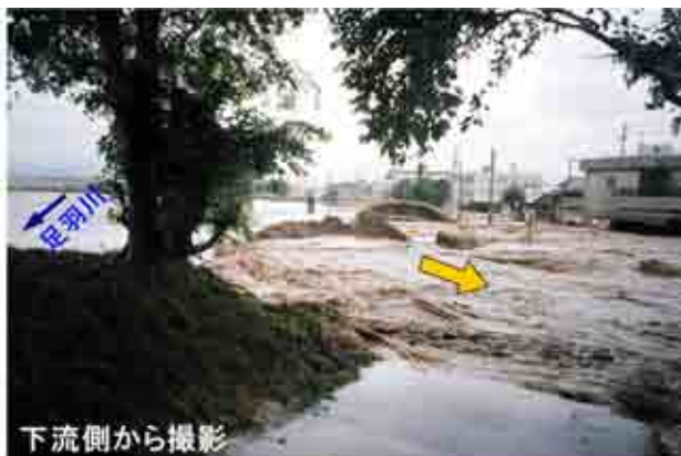
写真-1 足羽川破堤地点
