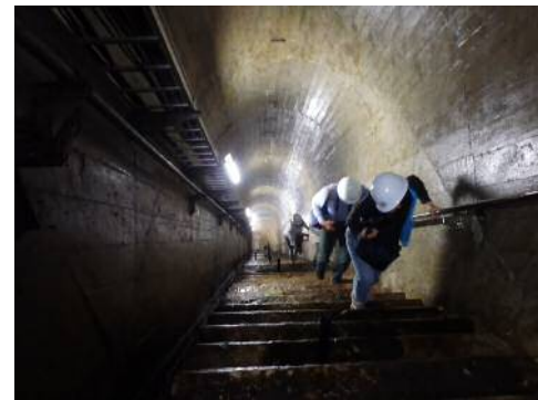
写真-3 監査廊階段（約 60 段、18 m）
