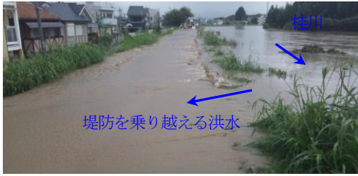
図-2 久我地区堤防越水
