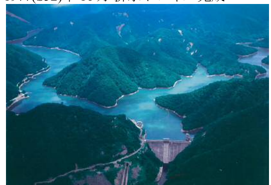
写真-1 笹生川ダム全景
