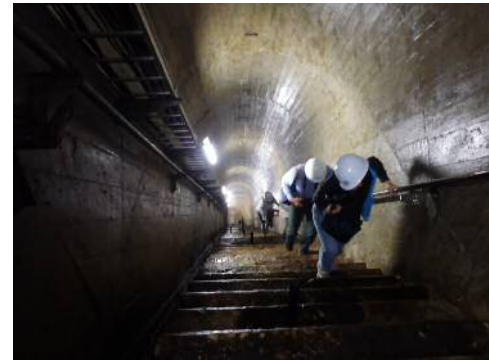
写真-3 監査廊階段（約 60 段,18 m）
