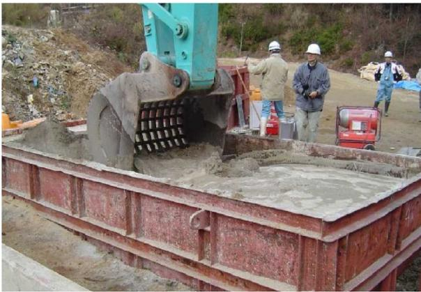
写真 INSEM-Fタイプの施工状況
