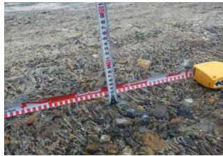
写真5 WJはつり状況 写真6 はつり後の床版表面
