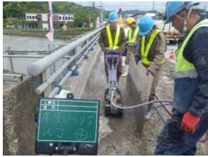
写真5 WJはつり状況 写真6 はつり後の床版表面
