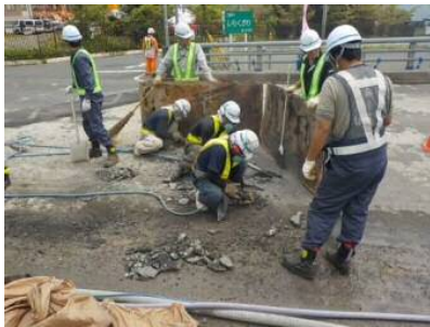
写真14 付着 AS 撤去状況
