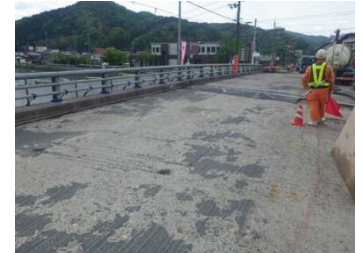
写真4 AS切削後の床版表面
