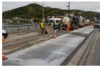
写真11 特殊コンクリート打設完了状況
