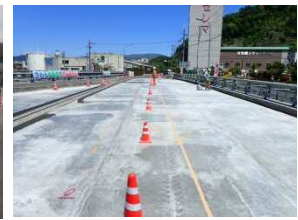
写真11 特殊コンクリート打設完了状況
