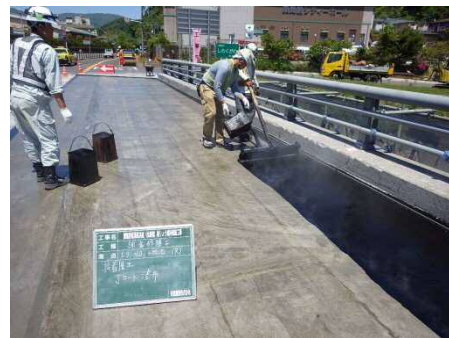
写真12 舗装接着材塗布状況
