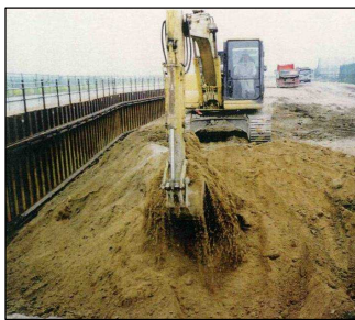
写真-1 堤体材料の砂質土
