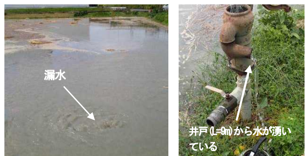
写真-5 漏水状況 (R5地点)
