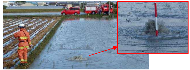
写真-3 漏水状況 (久御山地区R5地点)
