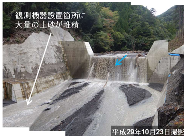
写真-2 台風21号後の観測箇所周辺の状況 観測箇所周辺を下流側より撮影
