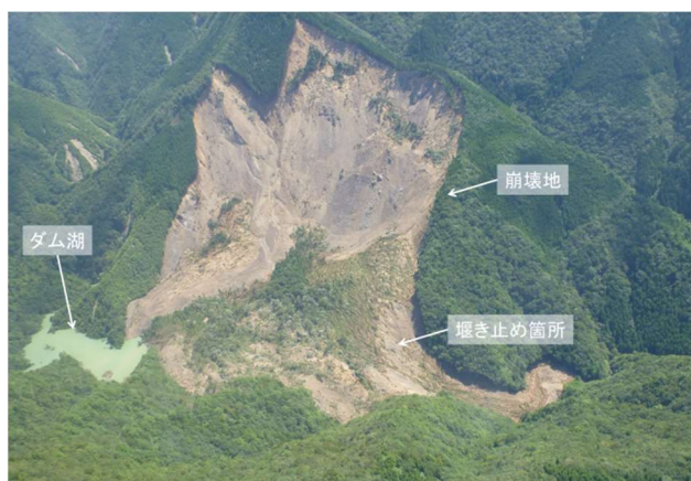
図-2 栗平地区における崩壊と天然ダム
