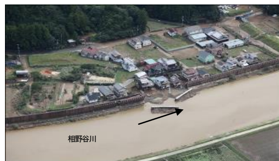
写真-1 高岡輪中堤の転倒
