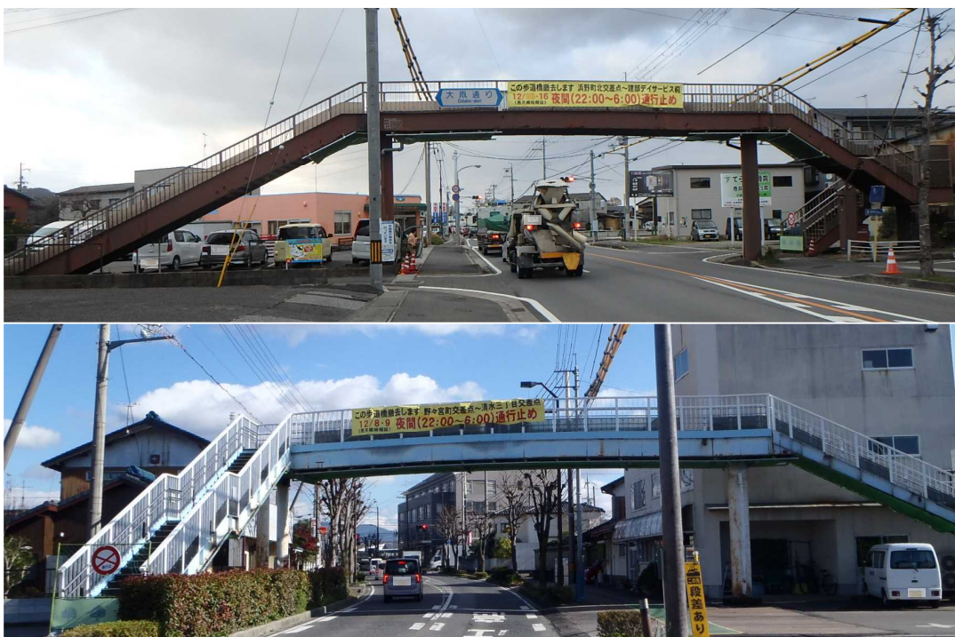
図-2 撤去前状況写真(上: 建部歩道橋 下: 東中野歩道橋)
