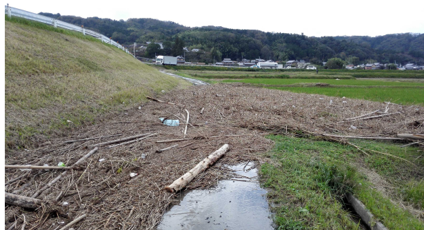
写真-2 遊水地内ゴミ堆積状況(長田)
