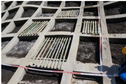
図-3 法枠工内の設置状況
