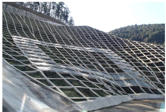
図-12 施工直後の様子(2017年2月)
