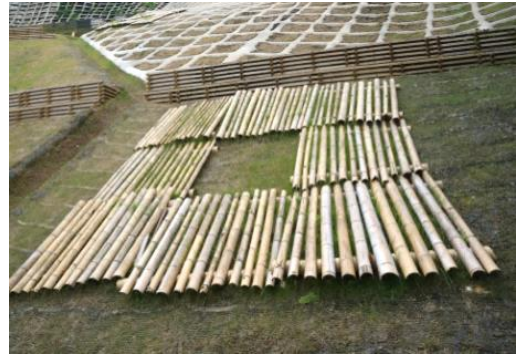
図-5 伏工内の設置状況
