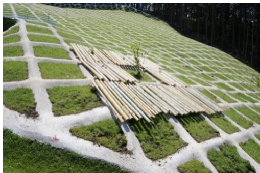
図-4 簡易法枠工内の設置状況
