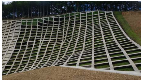
図-1 2014年度施工の法枠工
