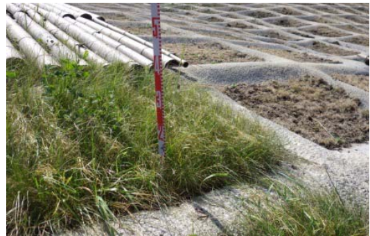
図-7 簡易法枠工内の生育状況
