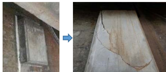
【補強鉄筋による断面修復】
