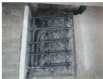
写真-11 過年度配筋状況
