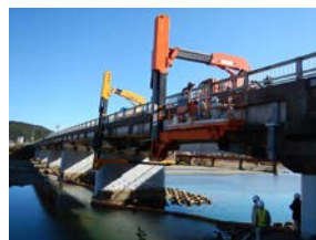
【点検車による近接調査】
