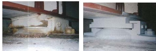
写真-10 金属溶射補修前後
