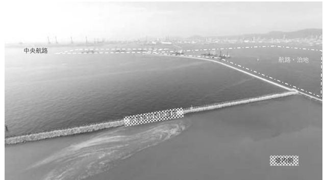
写真-6 揚土期間中の附帯施設の状況
