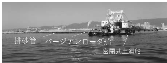
写真-2 バージアンローダ船による揚土状況
