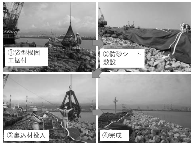
写真-4 西・南側護岸(1, 2, 5工区) 施工状況
