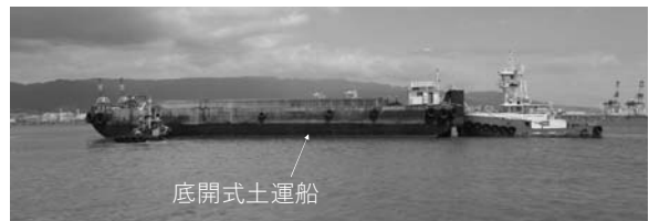
写真-1 底開式土運船による土砂投入状況
