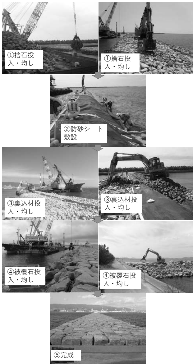
写真-5 東側護岸 (3, 4工区) 施工状況
