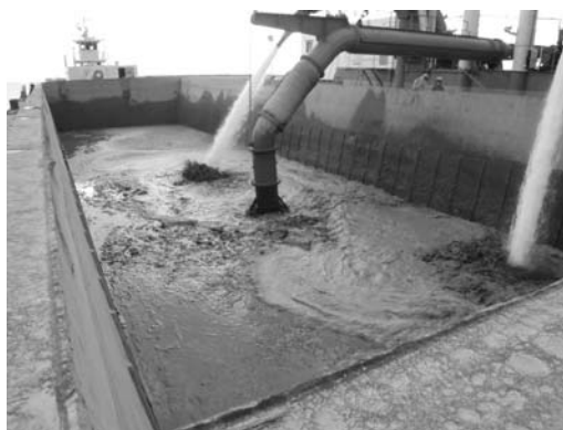
写真-3 バージアンローダ船による攪拌混合の状況
