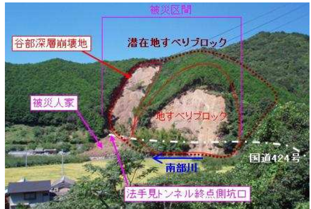
写真-1 被災当初の全景
