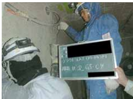
図-11 グラウト再注入状況
