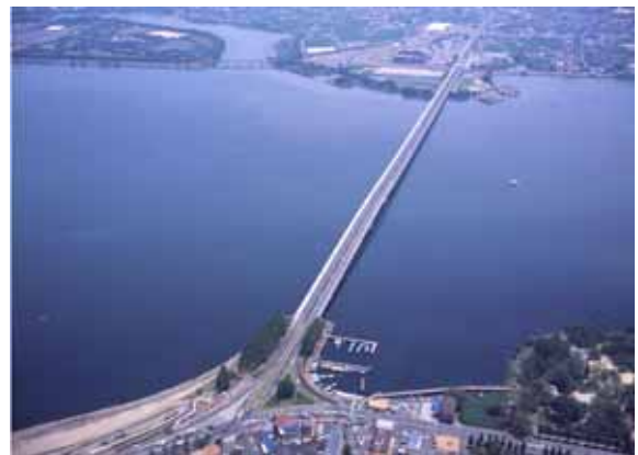
図-2 近江大橋 全景写真
