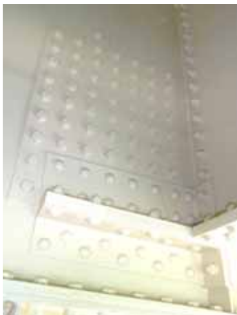
写真-2 補強状況
