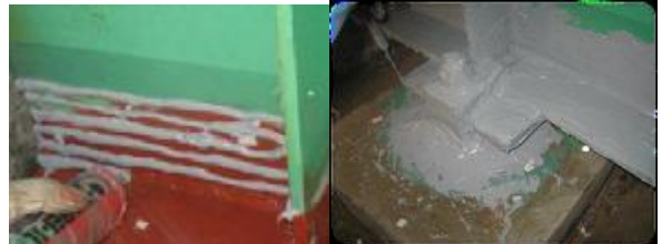
(写真-8) シリコンシーリング施工
