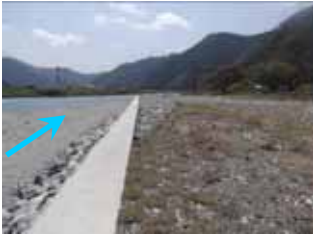
写真-8 高水敷切土箇所
