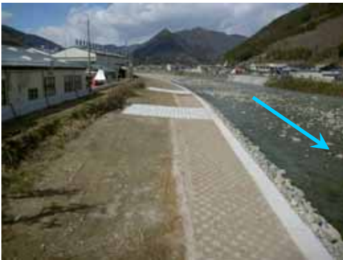
写真-5 災害復旧工事完了全景
