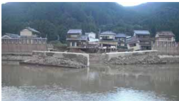
写真 3 特殊堤転倒状況
