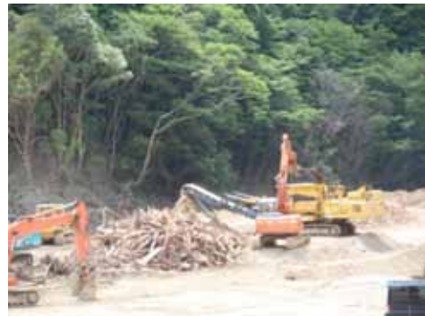
写真-8 木材破砕機による伐採材チップ化
