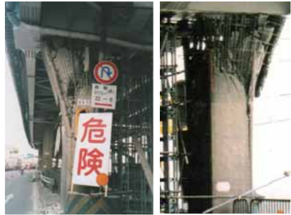
(a) 西面(P465 山側柱) (b)東面(P465 山側柱) 17)
