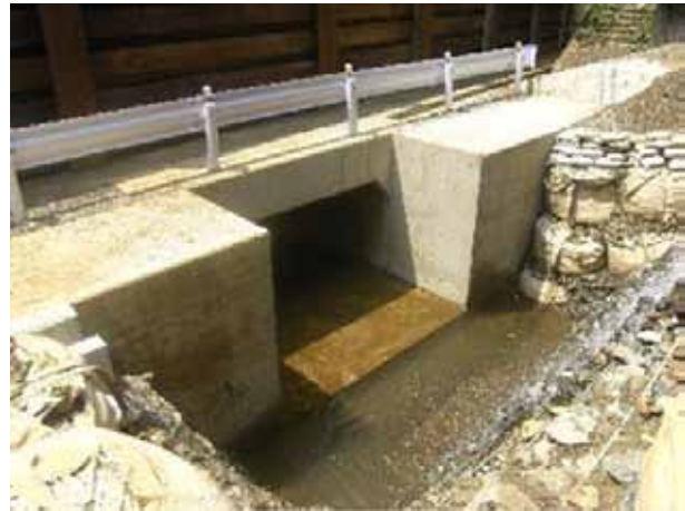
図-13 施工済みBOX上流部
