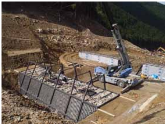
写真-5 鋼製枠組立状況
