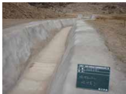
写真-2 施工状況
