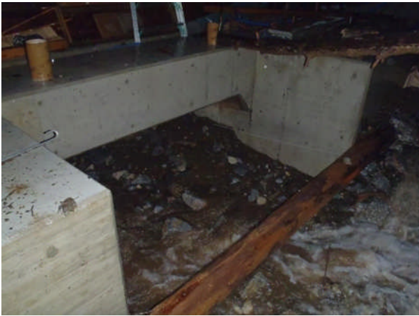
図-15 土石流捕捉状況
