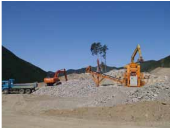
写真-4 ジョークラッシュャによる鋼製枠中詰材の製造状況
