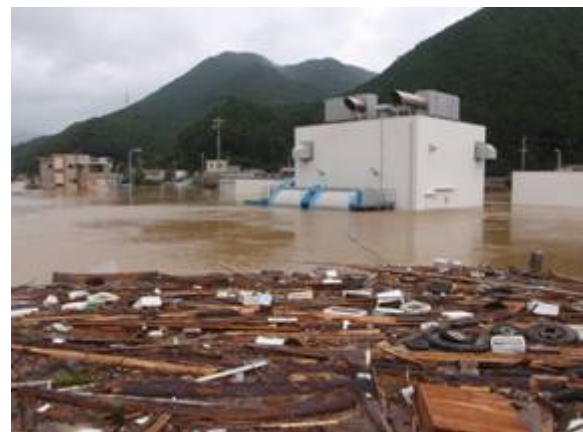
写真 2 水没した鮎田水門のポンプ場
