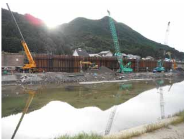
写真 4 鋼矢板二重締切
