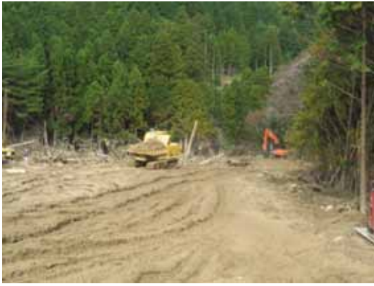
写真-3 上池埋戻し状況
