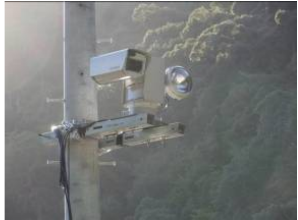
図-8 投光器を設置した固定カメラ(栗平)
