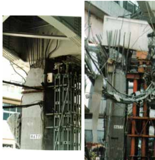
(a) P472 橋脚 17) (b) P477 橋脚
