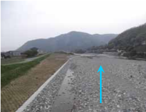
写真-1 2011年出水被災後全景
