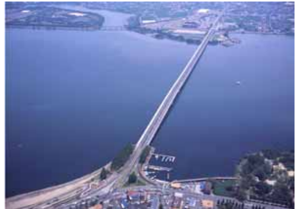
図-2 近江大橋 全景写真
