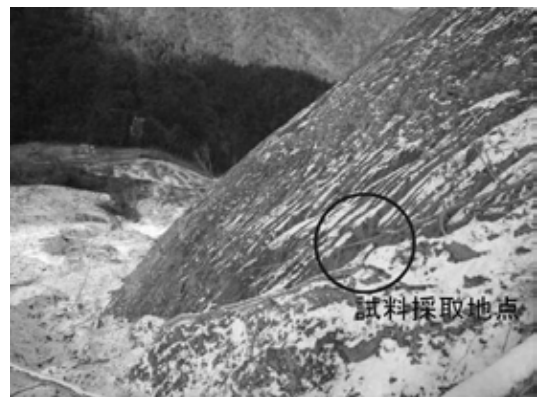
写真-2 長殿地区の斜面下部の直線的な岩盤の滑落崖
