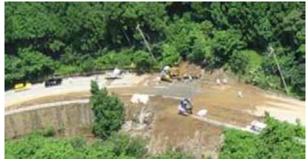
図-6 土石撤去状況
