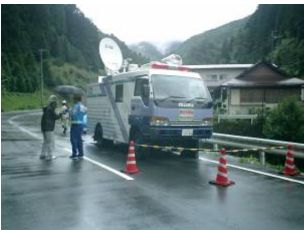
図-4 衛星通信車設置状況（北股）
