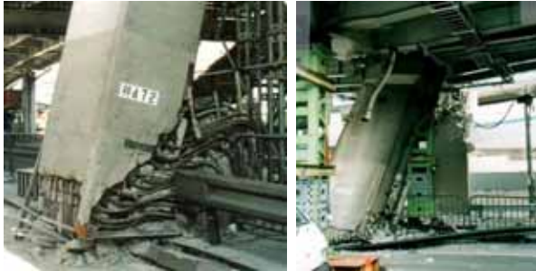
(a)P472 橋脚 (b)P477 橋脚
