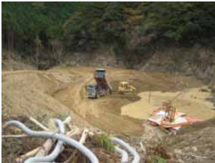
《STEP③：応急排水路の構築（鋼製枠）》
