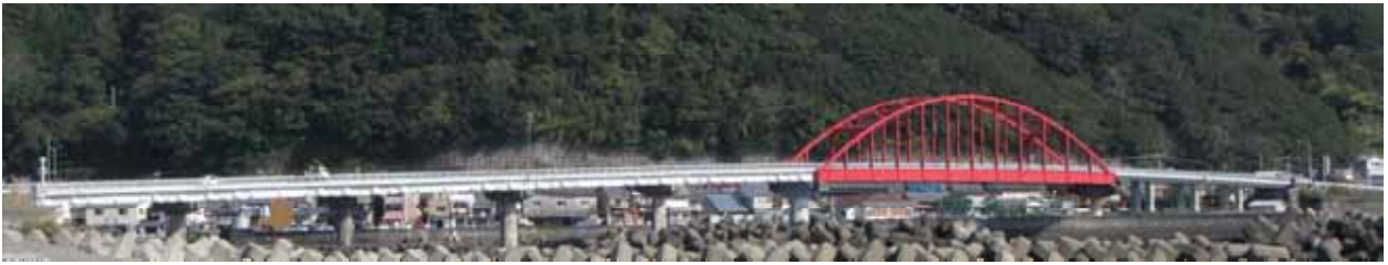
写真-2 古座大橋全景（串本側海岸より）
