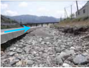
写真-7 高水敷盛土箇所
