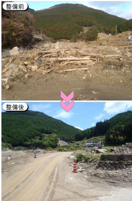
《仮設昇降設備》
