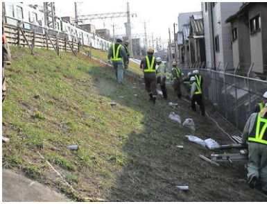
写真-2 鉄道盛土における排水パイプの設置例
