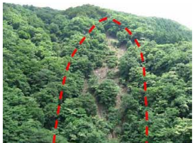
図-7 表層崩壊状況
