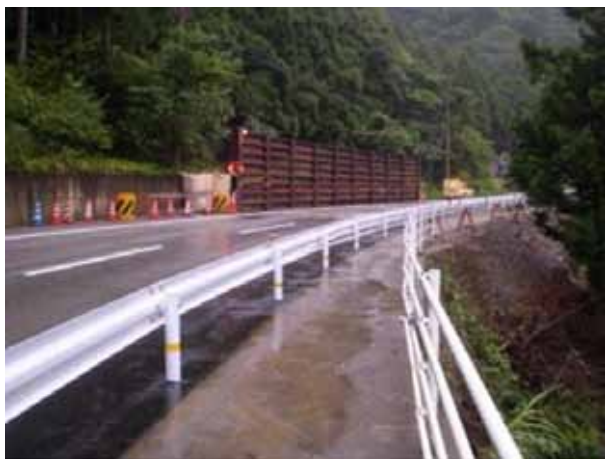
図-9 仮設防護柵設置状況
