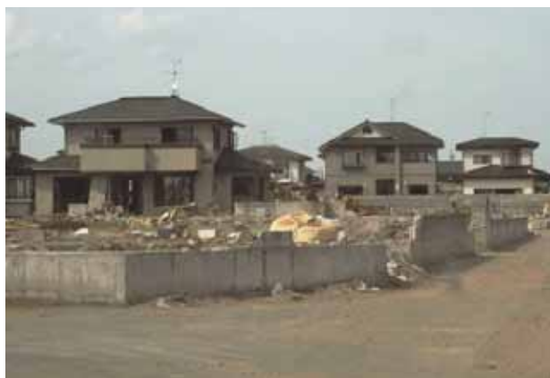
写真-2 津波による流出に耐えた住宅 8)
