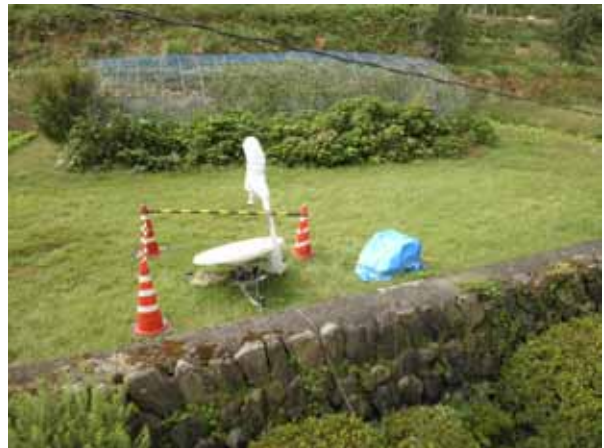
図-5 自治体向け映像配信用Ku-SAT設置状況
