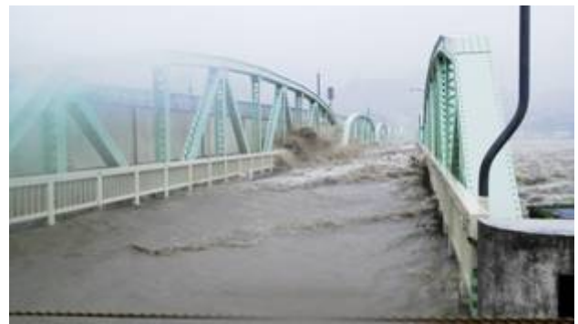
写真 1 橋梁付近状況
