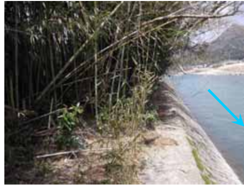
写真-10 竹林の根により被災を受けなかった護岸
