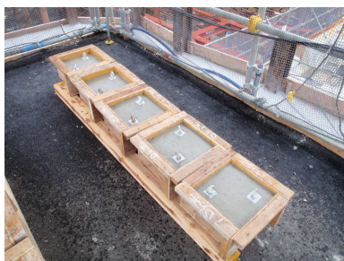
写真-1 試験体作成状況
