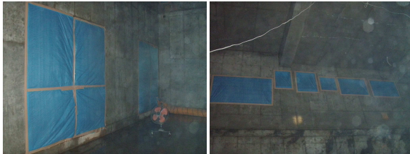
写真-3 開口部養生状況
