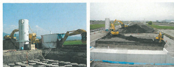
【改良土の排出状況】 【改良土敷き均しの状況】
