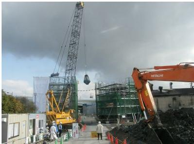
写真-8, 9, 10 圧入オープン基礎工施工状況
