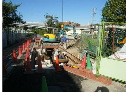
写真-4 仮覆工・排泥ピット設置、計測機器設置状況
