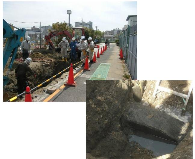
写真-2. 3 下水幹線φ1800 現状調査試掘状況写真
