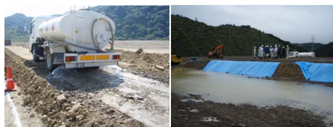
写真-4.1 散水試験状況と水浸状況
