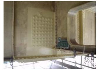
写真-2 主桁ウェブの疲労亀裂と補修状況
