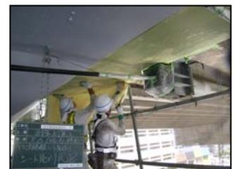
写真-4 断面修復及びメッシュシートによる剥落防止
