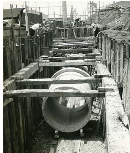
写真-1 下水幹線φ1800布設状況写真（1967年度）
