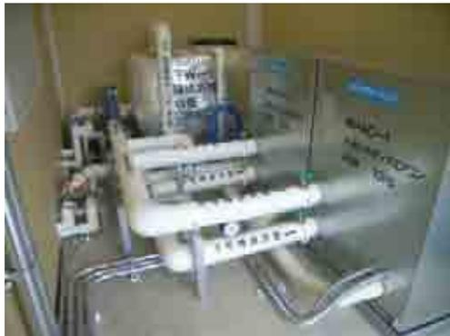
写真9 水冷ヒートポンプ (機械室内)
