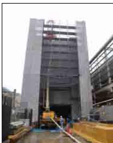
写真-6 中継ポンプ車による打設状況
