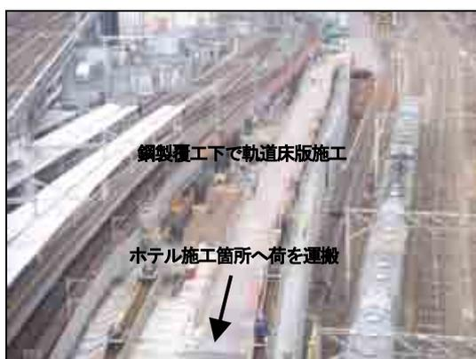
写真-4 鋼製覆工通路
