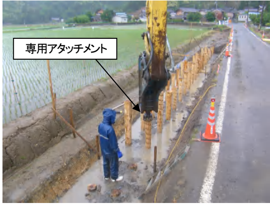
写真3 専用アタッチメントでの打設
