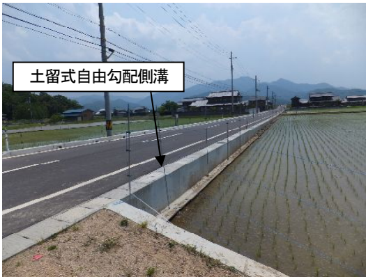
写真4 土留式自由勾配側溝の状況(6ヶ月経過)
