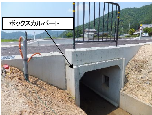
写真5 ボックスカルバートの状況(6ヶ月経過)
