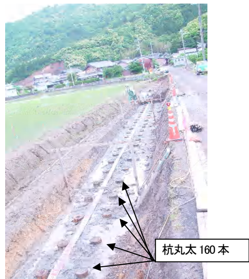
写真-2 土留式自由勾配側溝基礎(一部分)
