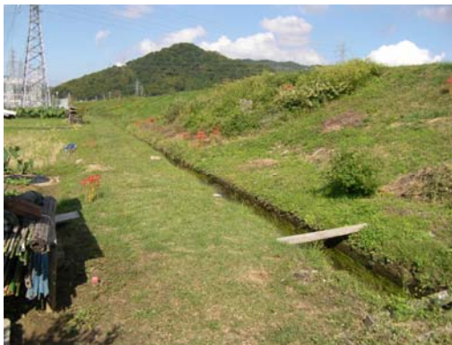
写真-5 ドレーン工施工前
