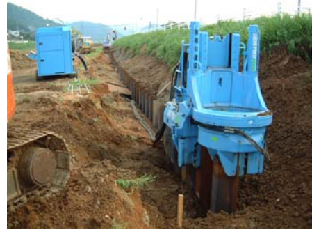
写真-1 矢板打設状況
