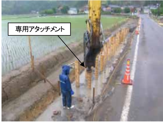
写真3 専用アタッチメントでの打設
