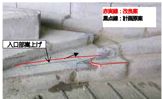
写真-5 分水路改良後（改良案）
