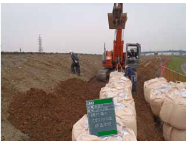
写真6 盛土施工状況
