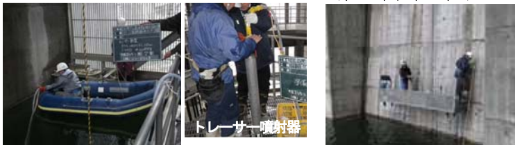
図-8 J8, J9 継目トレーサー調査状況
