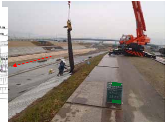
写真7 川裏からの施工状況
