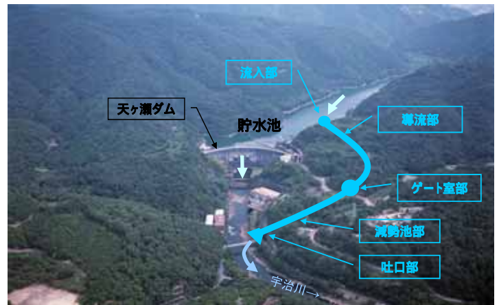
図-2 トンネル式放流設備概要図 (施設配置図)
