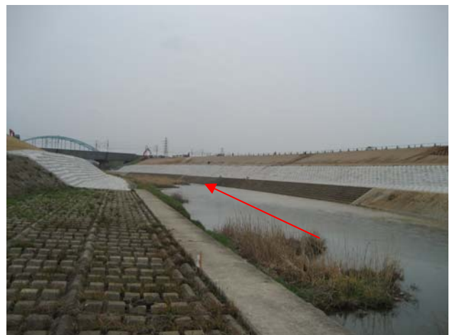
写真8 施工完了後も保持されている環境
