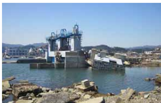
図-1 東日本大震災における被災状況
