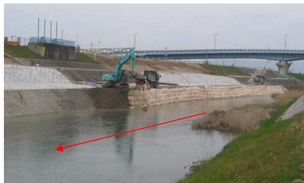
写真5 川表側腹付け盛土のイメージ
