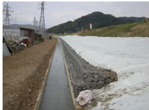
写真-7 ドレーン工施工後
