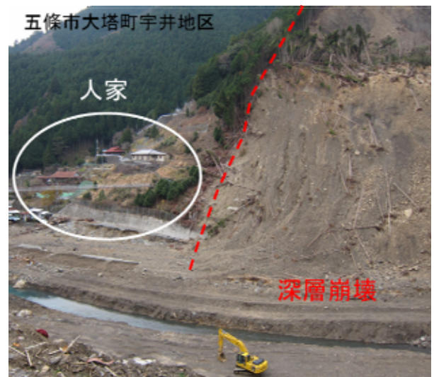
写真-2 深層崩壊（五條市大塔町宇井地区）
