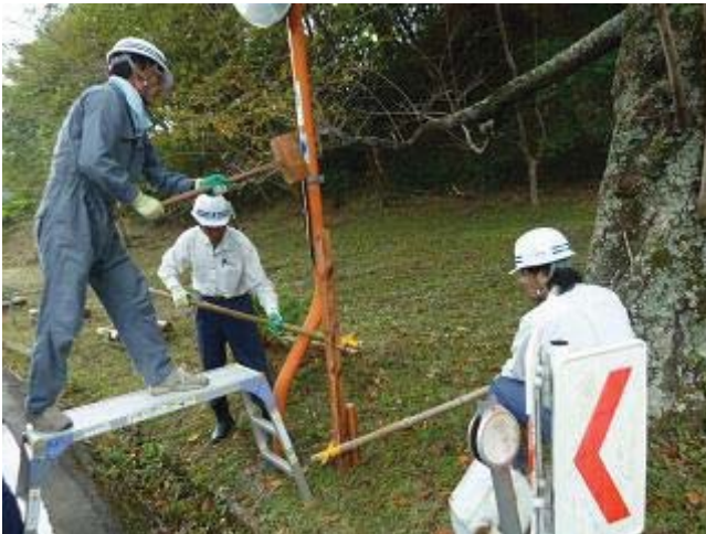
写真-4 キロポスト設置作業
