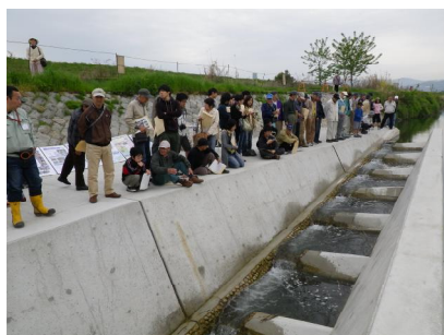
写真-2 H23年3月完成の魚みち (芥川1号井堰)
