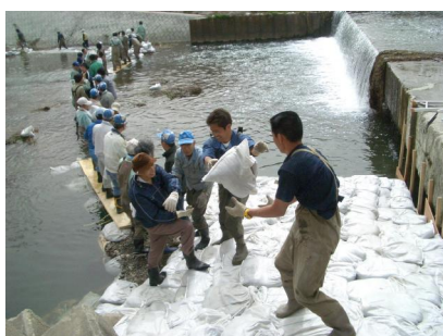
写真-1 H17年の仮設魚みちの整備状況 (芥川1号井堰)
