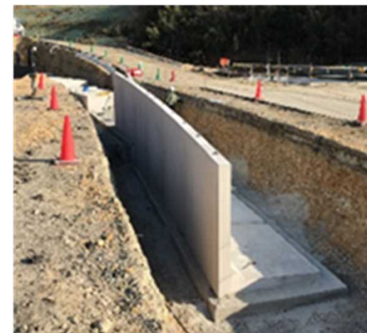
擁壁設置状況
