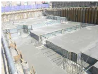
先行埋戻し工法 (キーストン型枠)
