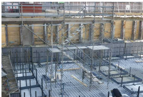
先行埋戻し工法
