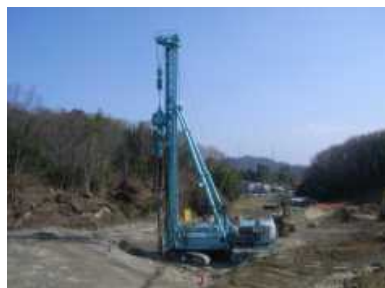
SCP 杭打設状況
