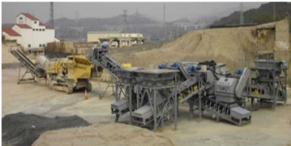
土砂混合システム近景【土壌くん】
