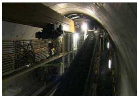
シールド現場
