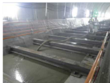
流動化処理土打設状況
