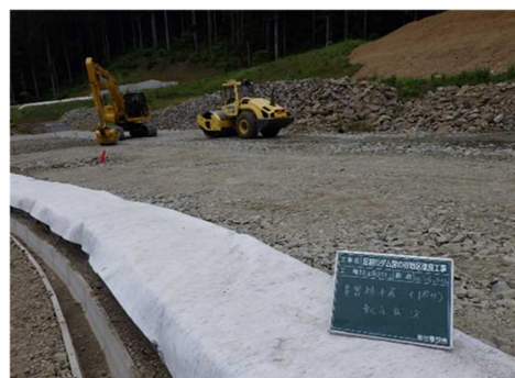
トンネルズリの活用事例 （基盤排水層としての活用）
