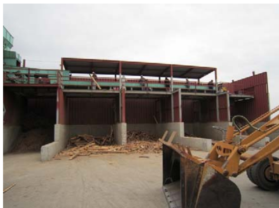
木質廃棄物の手作業による分別
