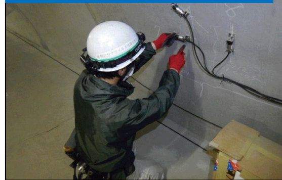
共同溝躯体のひび割れ調査
