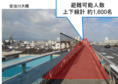
写真② 歩道部 (指定緊急避難場所)
